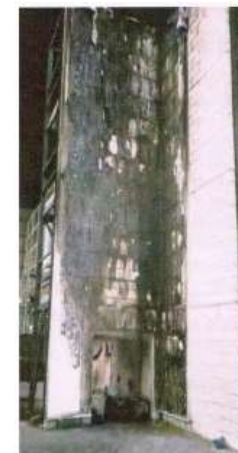
Módulo después del ensayo sin barreras.
