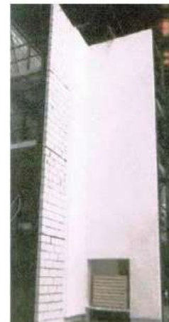
Módulo antes del ensayo
