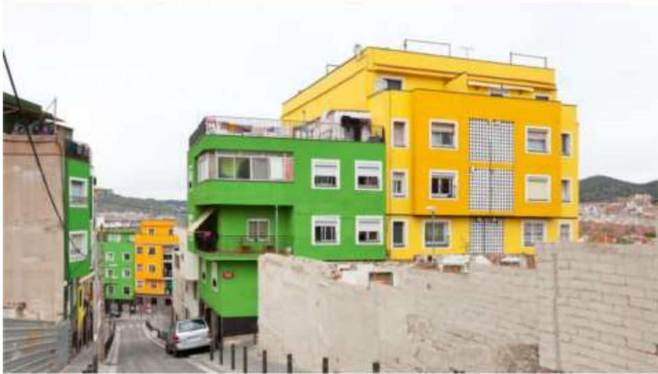
SANTA COLOMA RENOVEM ELS BARRIS
