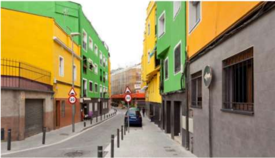
SANTA COLOMA RENOVEM ELS BARRIS
