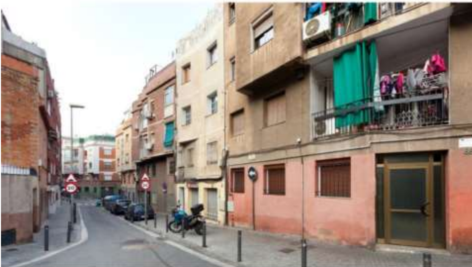
SANTA COLOMA RENOVEM ELS BARRIS
