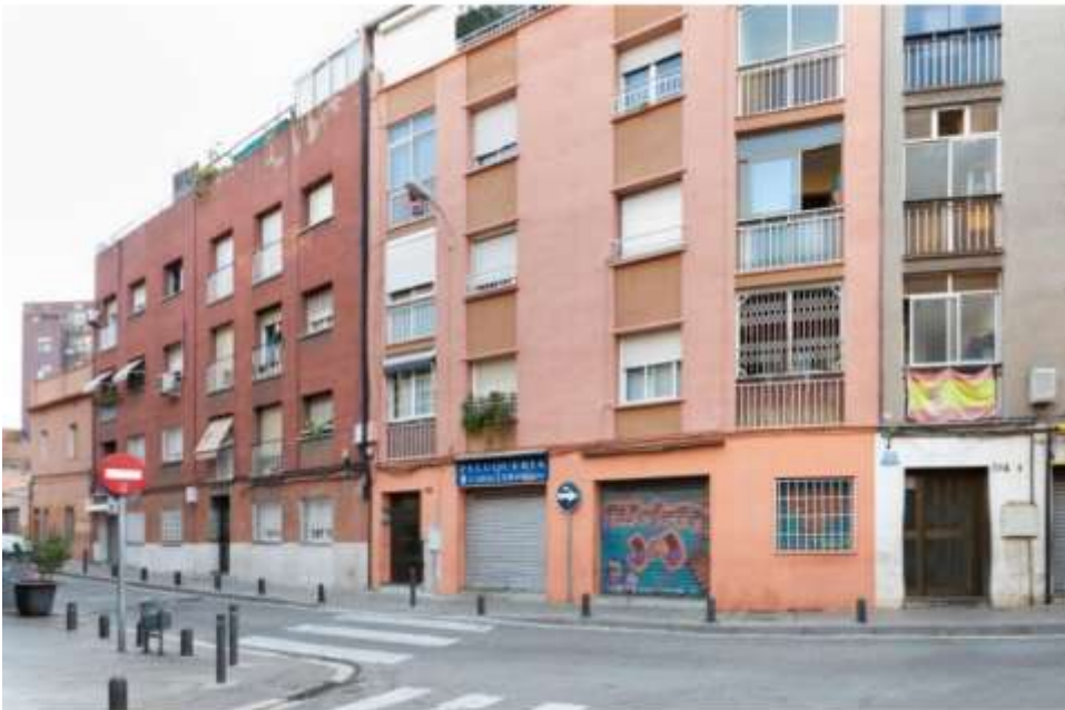
SANTA COLOMA RENOVEM ELS BARRIS
