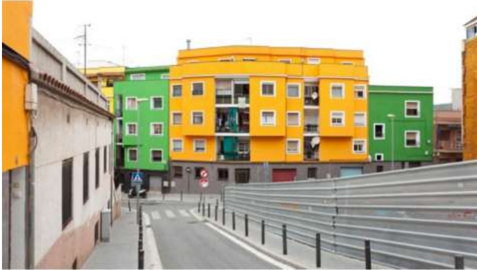
SANTA COLOMA RENOVEM ELS BARRIS
