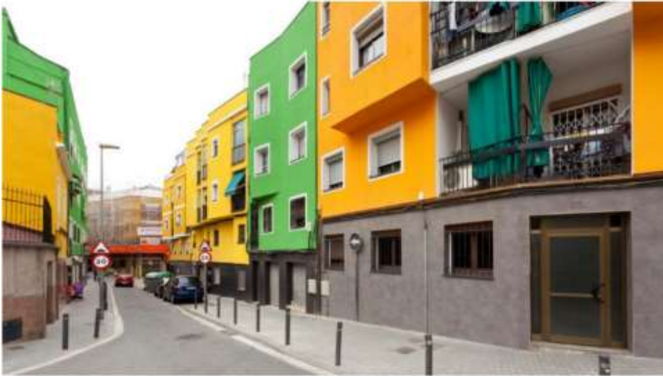
SANTA COLOMA RENOVEM ELS BARRIS
