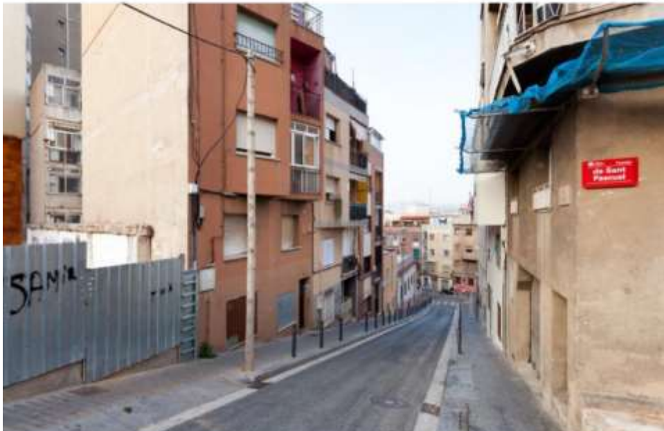
SANTA COLOMA RENOVEM ELS BARRIS
