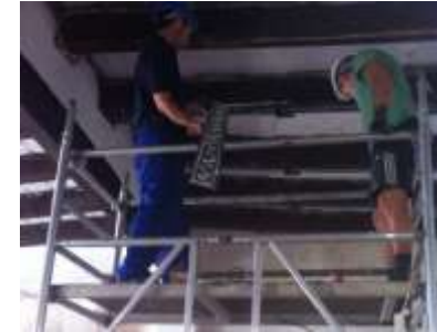
4. Aplicar el adhesivo en toda la superficie de la pletina 1
