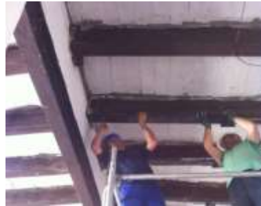
2. Marcar primer y ultimo taladro con la punta del tornillo barraquero
