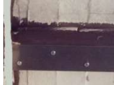
7. Colocar el resto de tornillos barraqueros en la pletina 1
