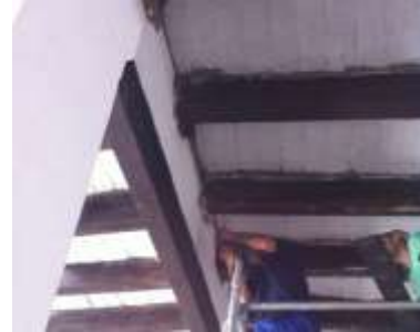
3. Taladrar el primer y último taladro, con broca de \text{Ø}7 mm y profundidad 11 cm
