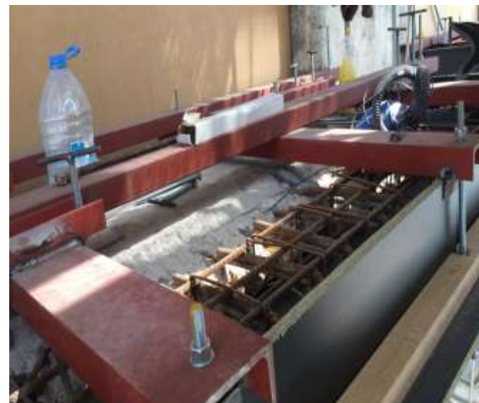
ENCOFRAT «IN SITU»
