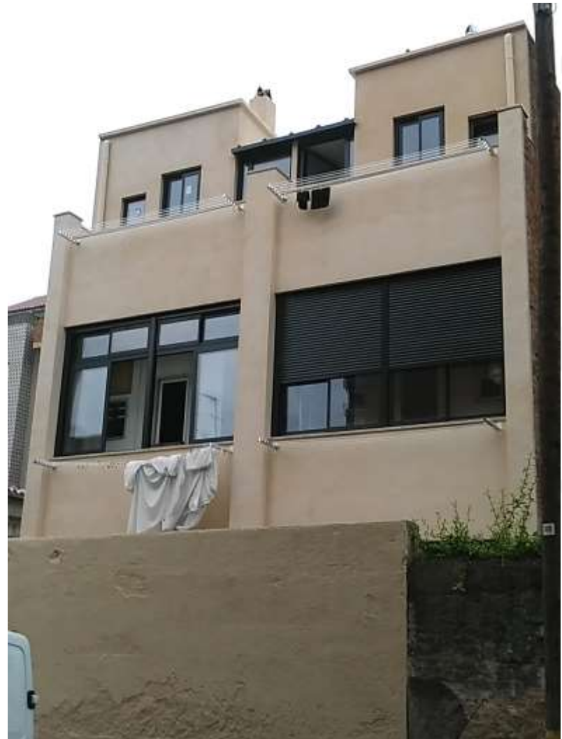
Bascònia, 17. Rehabilitació de la façana posterior amb tractament d'eficiència energètica i sostenibilitat: recuperació de terrasses, aïllament tèrmic en finestres, homogeneïtzació cromàtica.
