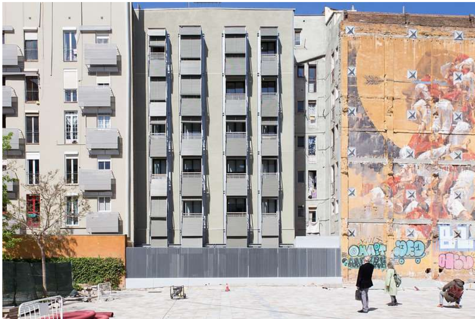
Carrer Lope de Vega. Rehabilitació de la façana posterior sencera: balcons i finestres nous per millorar la lluminositat.
