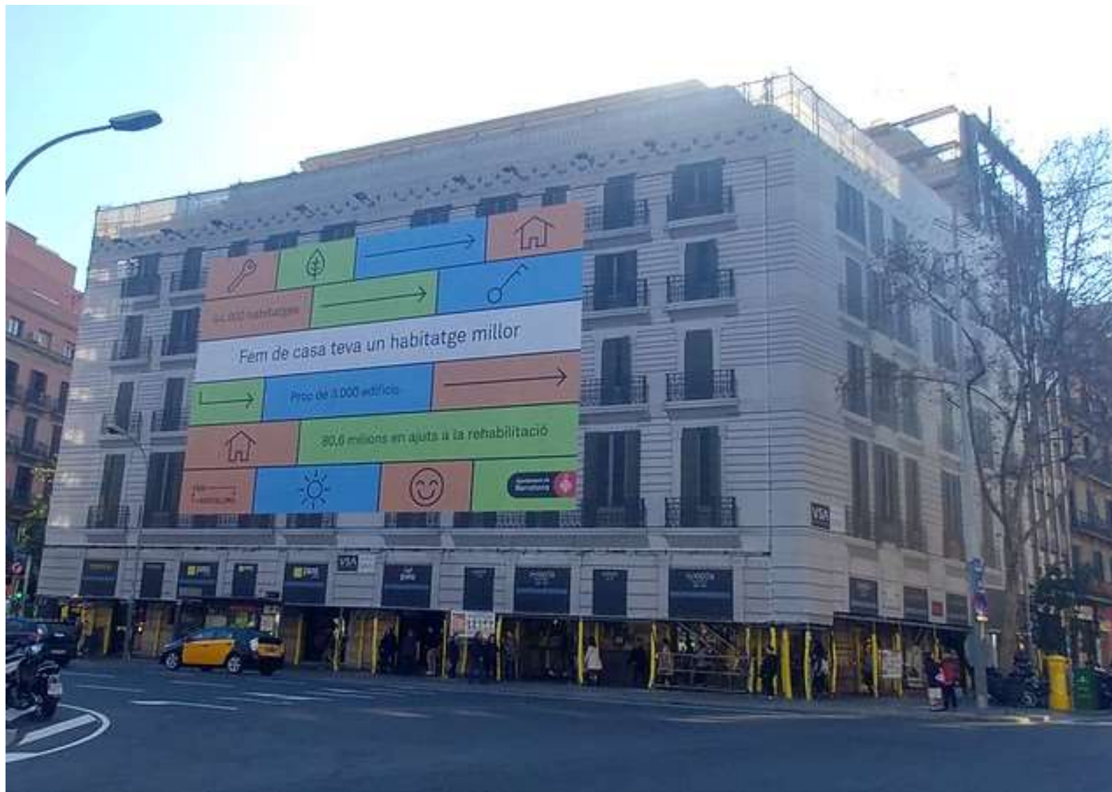
Plaça Urquinaona. Rehabilitació de la façana i l'interior dels habitatges.
