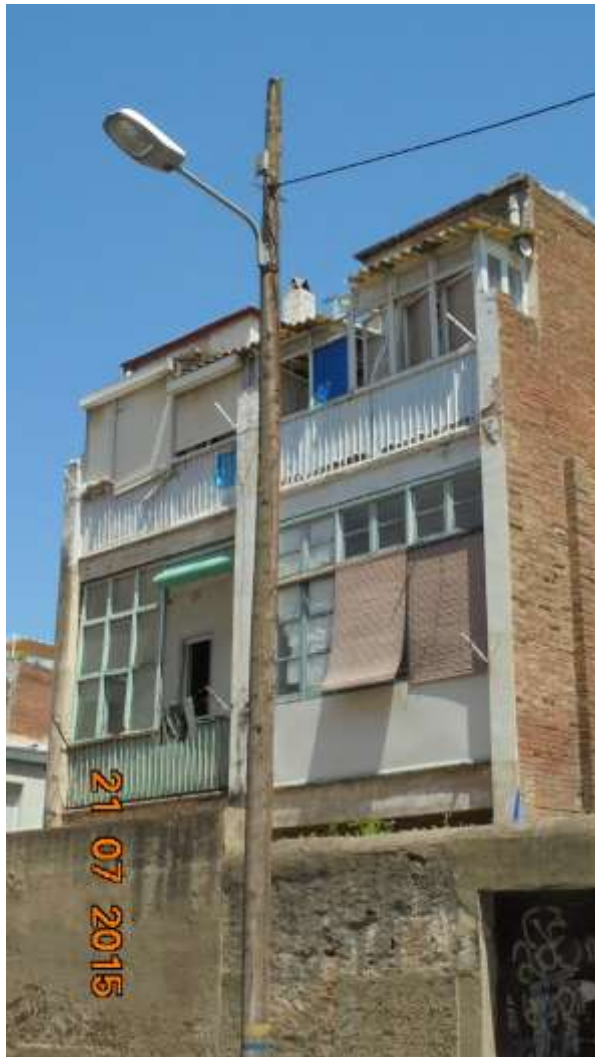
Bascònia, 17. Rehabilitació de la façana posterior amb tractament d'eficiència energètica i sostenibilitat: recuperació de terrasses, aïllament tèrmic en finestres, homogeneïtzació cromàtica.
