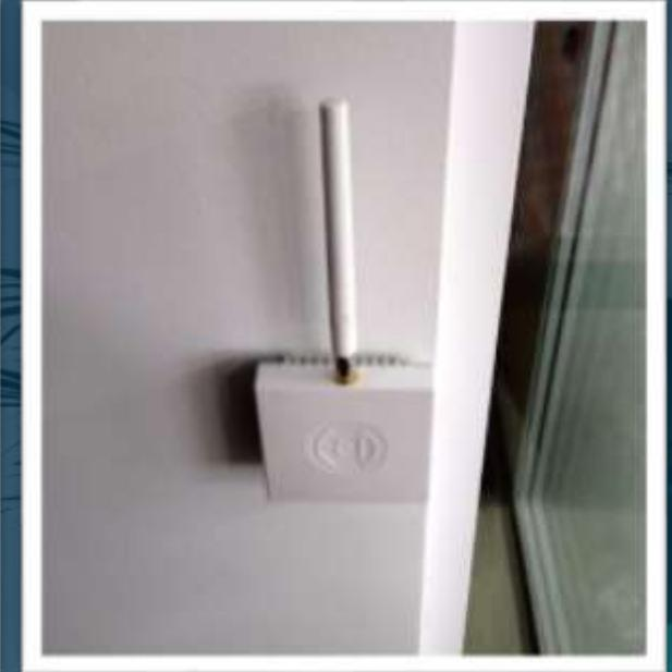
**Sensor de temperatura: verifica que la temperatura esté dentro de los parámetros**
