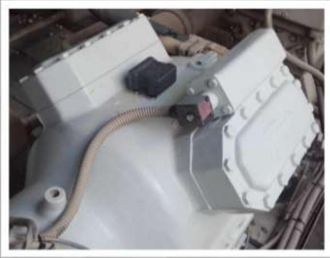
**Acelerómetro:** mide las vibraciones de las bombas para determinar si tiene un comportamiento anómalo
