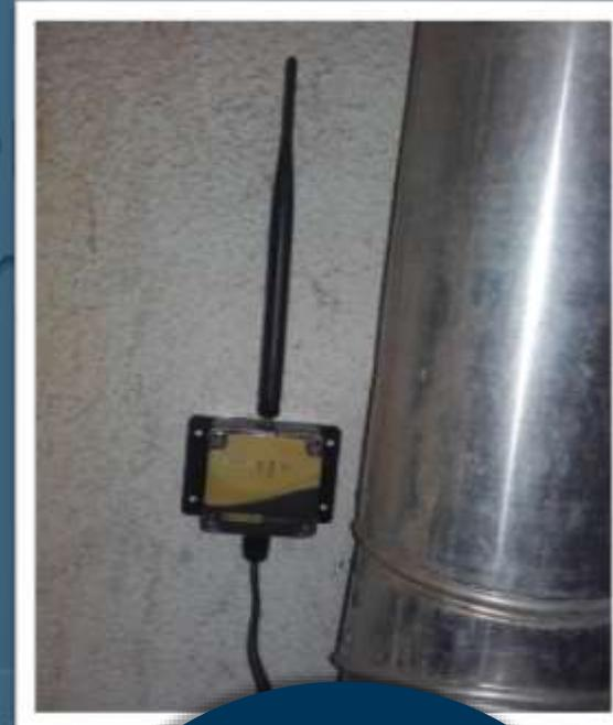
**Sensor de temperatura agua fría:** verifica que el agua fría de climatización tenga temperatura adecuada
