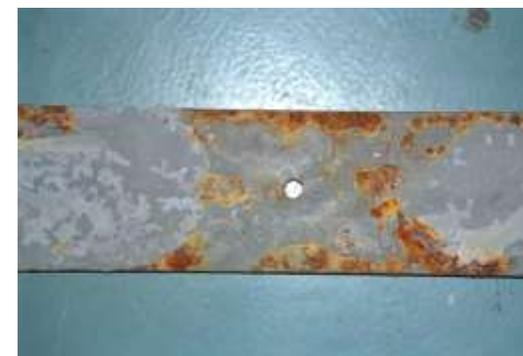
A causa dels problemes de durabilitat de les plaques metàl·liques, l'acer va ser progressivament substituït per sistemes CFRP
