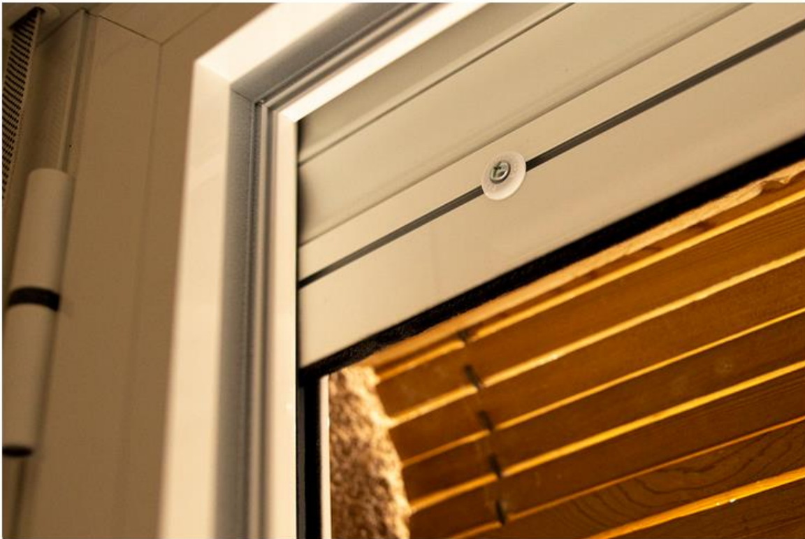
Más de 500 familias en situación de vulnerabilidad se han beneficiado de la línea de rehabilitación energética de la Fundación Naturgy.
